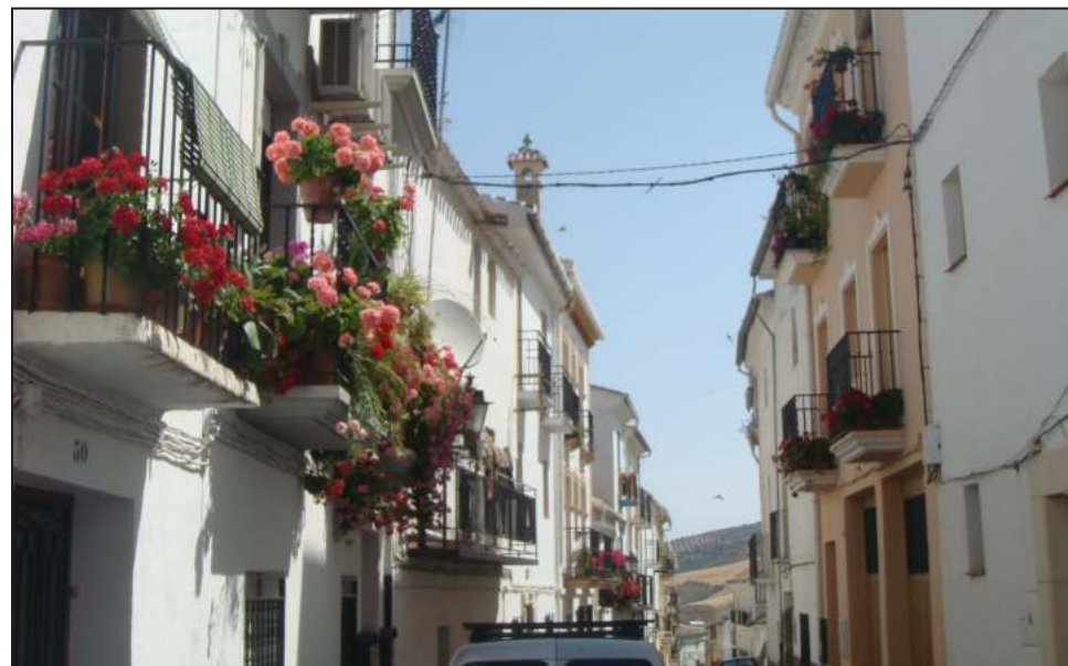
Las escenas de elevada cualificación paisajística, como el resto de ámbitos, no están exentas de incidencias paisajísticas derivadas de las infraestructuras eléctricas.
