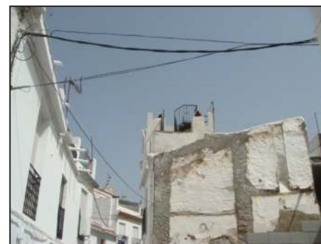
Los frecuentes cambios de orientación de los trazados sinuosos de las calles en los centros urbanos provocan que el cableado adopte soluciones dispares para su adaptación, entre los que destacan, por su incidencia, los cruces oblicuos (izq.). Aunque sin lugar a dudas, la situación espacial de mayor afección paisajística se produce con los trazados aéreos que sobrevuelan el viario en sentido longitudinal (dch.), tal y como se puede observar en la imagen, donde se superpone esta situación a la del recorrido en fachada impostado, por el encalado.
