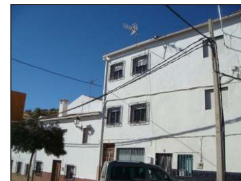
Los frecuentes cambios de orientación de los trazados sinuosos de las calles en los centros urbanos provocan que el cableado adopte soluciones dispares para su adaptación, entre los que destacan, por su incidencia, los cruces oblicuos (izq.). Aunque sin lugar a dudas, la situación espacial de mayor afección paisajística se produce con los trazados aéreos que sobrevuelan el viario en sentido longitudinal (dch.), tal y como se puede observar en la imagen, donde se superpone esta situación a la del recorrido en fachada impostado, por el encalado.
