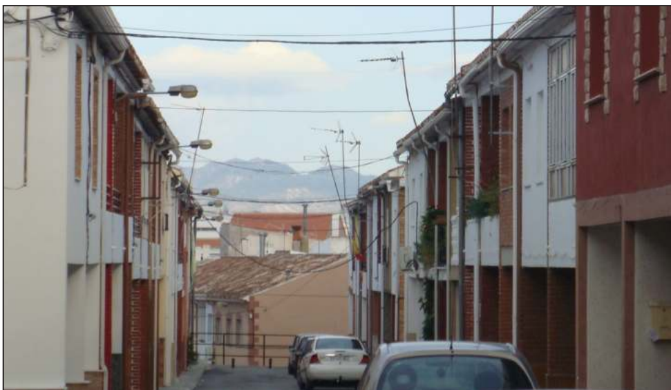
Ejemplo de una sucesión de cables donde se aprecia una flecha excesiva en uno de ellos, multiplicando el efecto visual negativo.
